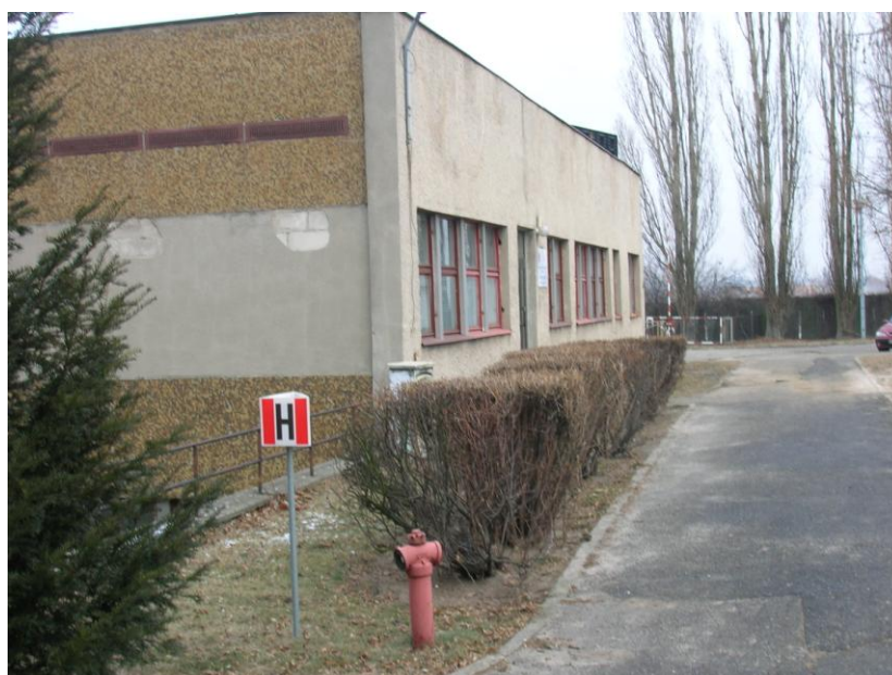
Zdjęcie 23. Przykładowa lokalizacja hydrantu zewnętrznego Nr 5 na działce z oznakowaniem.
