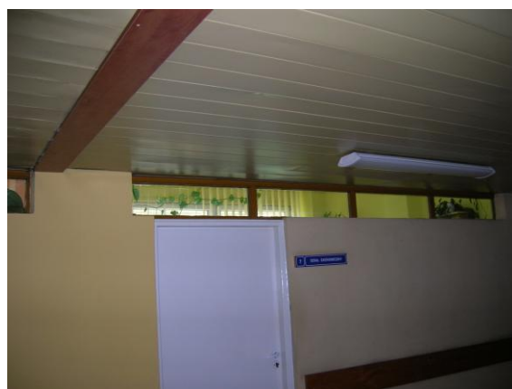
Zdjęcie nr 9 i 10. Przeszklenia bezklasowe w obudowie poziomych dróg ewakuacyjnych.
