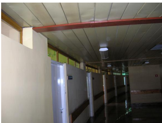
Zdjęcie nr 9 i 10. Przeszklenia bezklasowe w obudowie poziomych dróg ewakuacyjnych.
