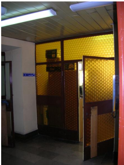
Zdjęcie nr 5. Bezklasowa obudowa klatek schodowych
