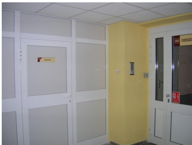
Zdjęcie nr 3 i 4. Bezklasowa obudowa klatek schodowych (przykład jednej z kondygnacji)
