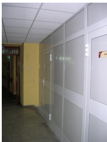
Zdjęcie nr 3 i 4. Bezklasowa obudowa klatek schodowych (przykład jednej z kondygnacji)
