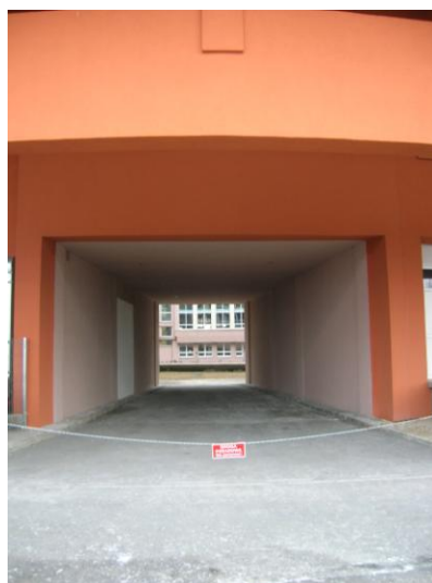
Zdjęcie 25. Możliwość wjazdu na dziedziniec wewnętrzny z drogi pożarowej (wys. > 4,2 m). Uczestniczyła w ćwiczeniach drabina 37 m.
